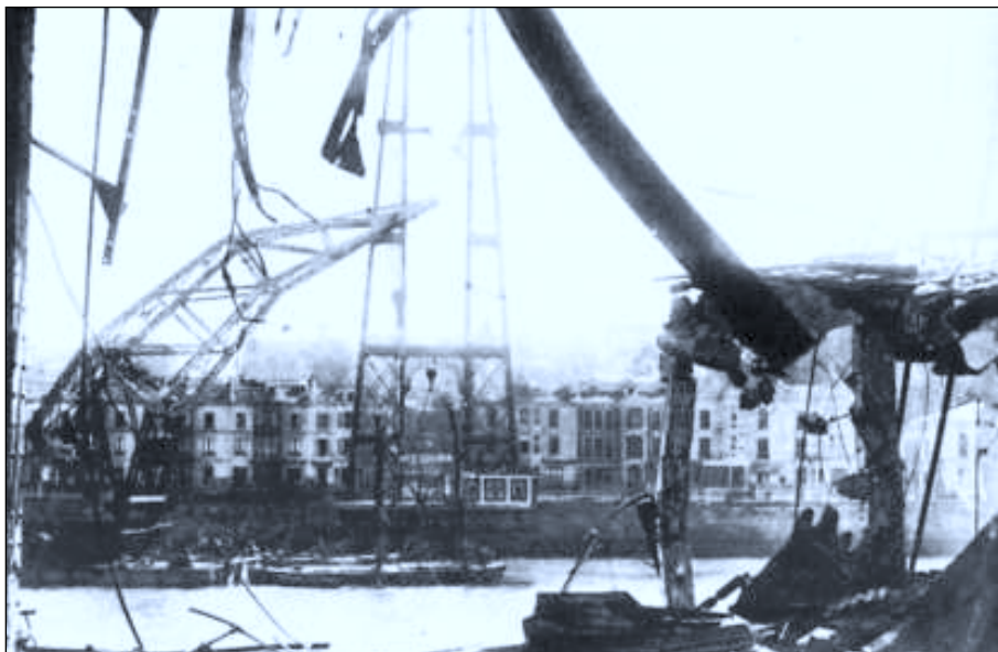
Fig. 5. Estación de embarque de Las Arenas tras la voladura del 16 de junio de 1937, con los restos del tablero sobresaliendo del agua, impidiendo el tráfico naval por la ría.
