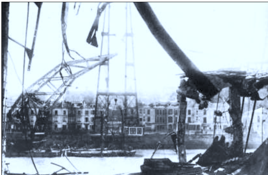
Fig. 5. Estación de embarque de Las Arenas tras la voladura del 16 de junio de 1937, con los restos del tablero sobresaliendo del agua, impidiendo el tráfico naval por la ría.
