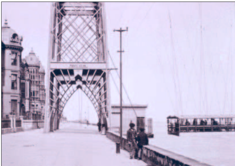
Fig. 6. Base de las torres del Puente Vizcaya y estación de embarque en el muelle de Portugalete. Foto Hauser y Menet.
