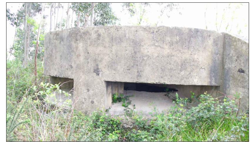
Vista general del bunker .
