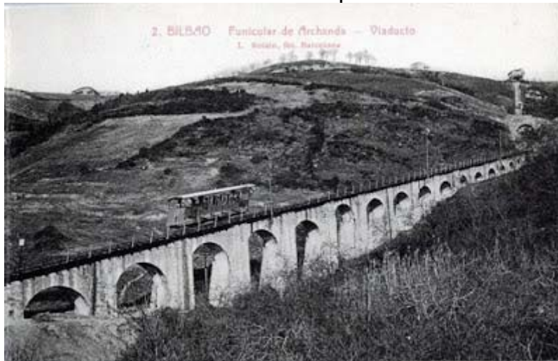
Junto al túnel de acceso a la estación inferior, la obra más espectacular del funicular de Artxanda fue el viaducto de 18 arcos que permitía superar los desniveles del terreno. Archivo EuskoTren/Museo Vasco del Ferrocarril
