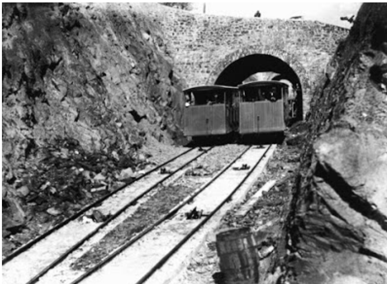
Mariano de Corral construyó las carrocerías de los dos coches del funicular de Artxanda. Archivo EuskoTren/Museo Vasco del Ferrocarril
