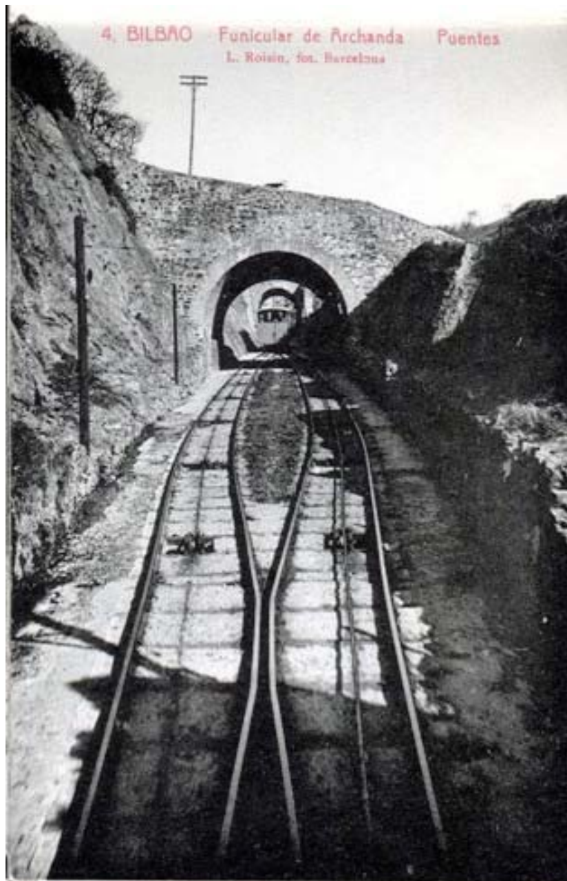
Vista del cruce sin piezas móviles establecido en el centro del trazado, según los principios del ingeniero Roman Abt. Archivo
