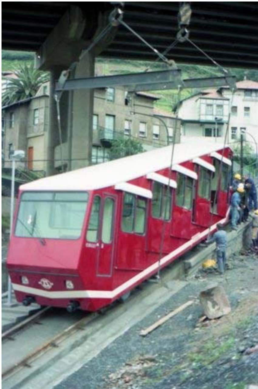
Colocación de los nuevos coches del funicular de Artxanda sobre la vía. Archivo EuskoTren/Museo Vasco del Ferrocarril
